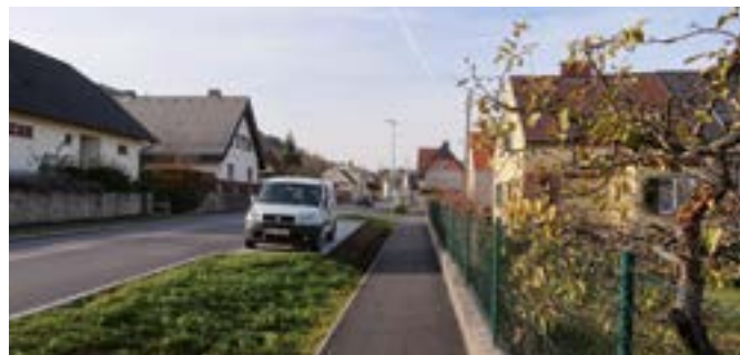
Hauptstraße / Ecke Gartenweg - neue Beleuchtung und Parkfläche
